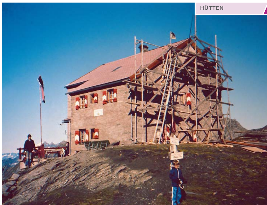
Die Hütte im Baugerüst während einer Arbeitswoche 1929
